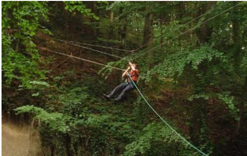
Bau einer Tiroler Seilbrücke (Kurs Wildnispädagogik )
