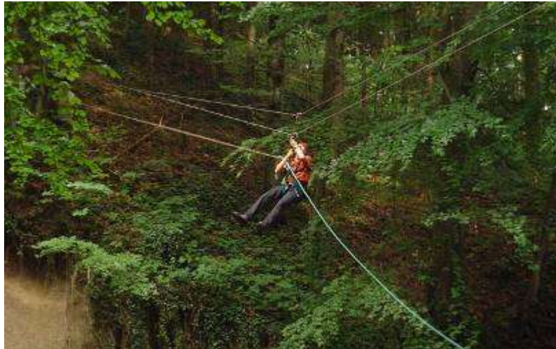
Bau einer Tiroler Seilbrücke (Kurs Wildnispädagogik )
