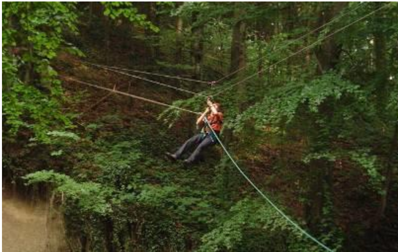
Bau einer Tiroler Seilbrücke (Kurs Wildnispädagogik )
