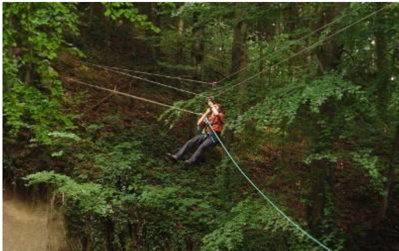
Bau einer Tiroler Seilbrücke
